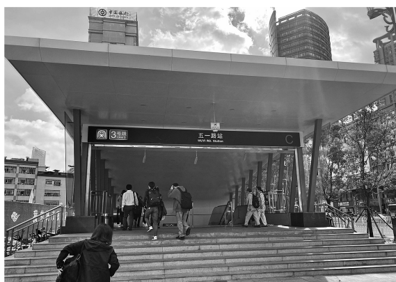
図19 地下鉄五一路駅
